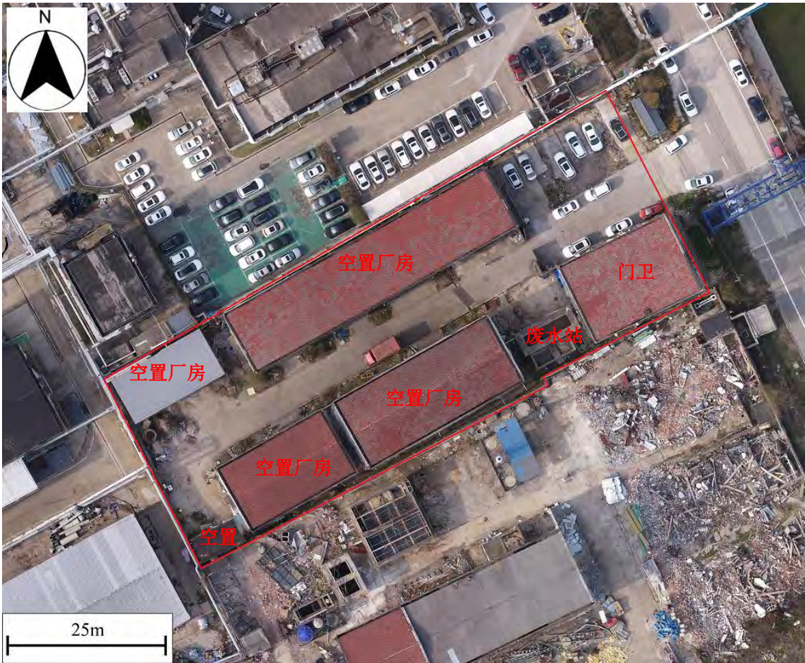
图 3.1-1 地块拆除前平面布置图（2023 年 3 月构筑物拆除前）
