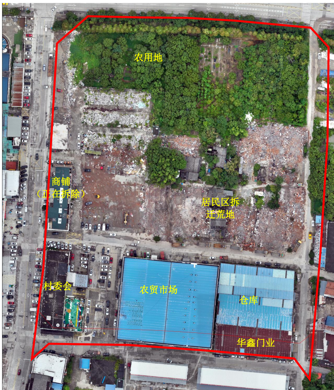
2.4-1 地块现场航拍图
