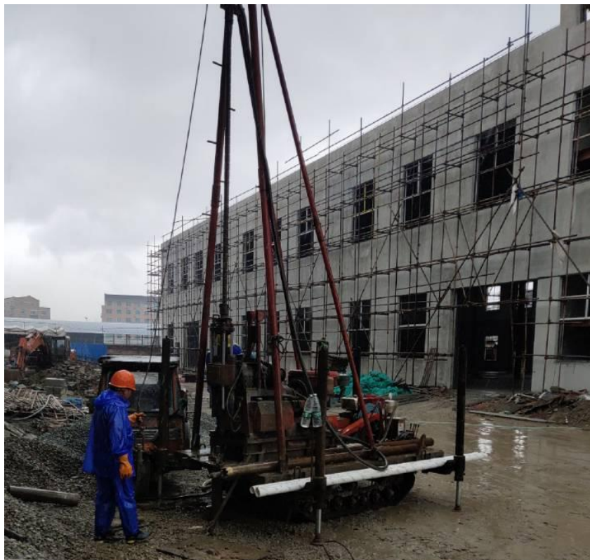
图 5.1-1 GXY-2Q 型工程钻机
